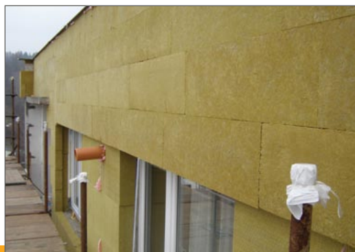
Ukázka aplikace výrobku Isover NF 333
