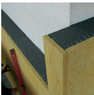
Detail nadpraží pro okno se špaletou šíře menší než 80 mm vyhovující ISO 13785-1 a ISO 13785-2
