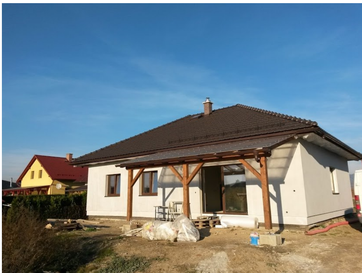
Fotografie domu po zateplení
