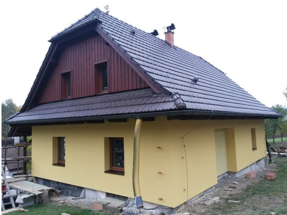
Fotografie domu po zateplení
