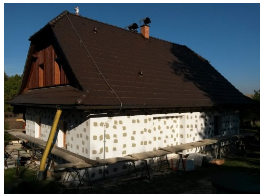
Fotografie domu před a v průběhu realizace zateplení
