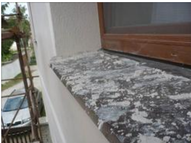
Zničené oplechování parapetu
