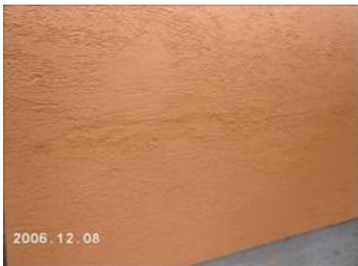
Nesprávně provedená rýhový struktura
