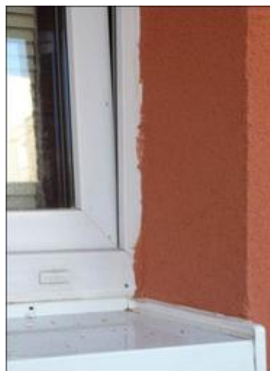
Nesprávné opracování omítky kolem rámu bez použití začíšťovacích lišt
