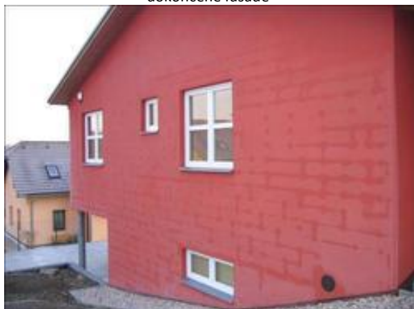
Pokus o vypěnění mezery mezi deskami tepelné izolace
