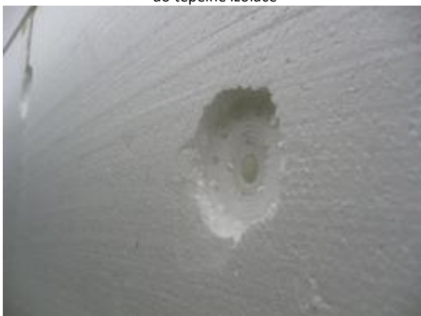
Nedostatečná kvalita kotvení – talíř kotevního prvku zatlačený do tepelné izolace
