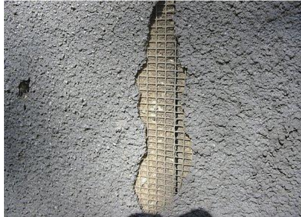
Odtrhávání desek od podkladu a poškození vnějšího souvrství
