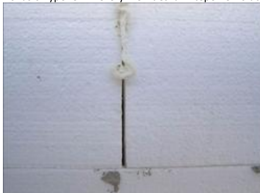
Pokus o vypěnění mezery mezi deskami tepelné izolace
