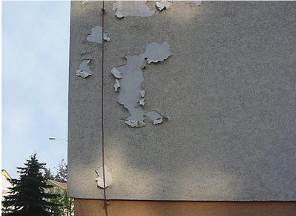
Projevy termodifúze vinou špatného pokládání desek
