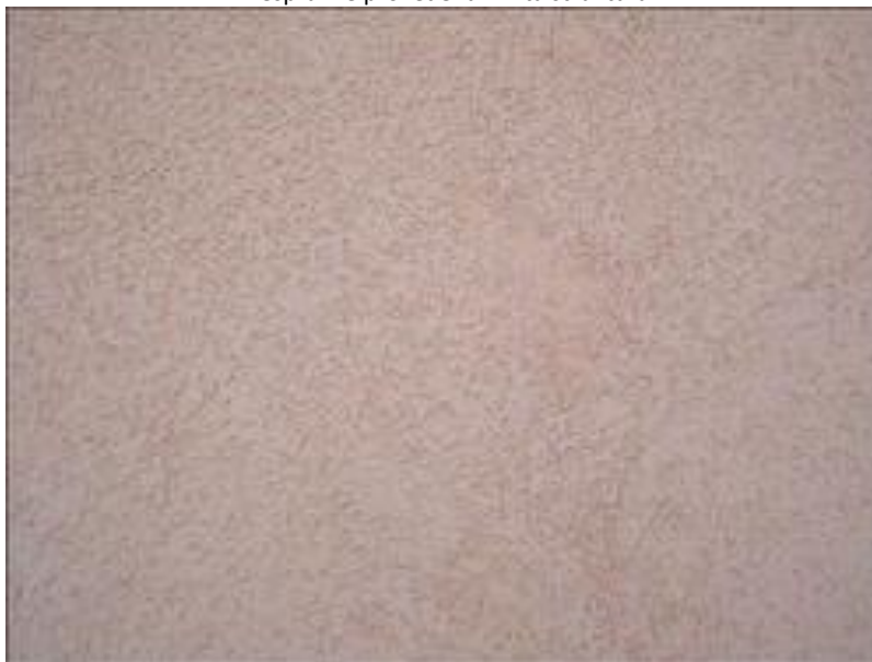
Nesprávně provedená zrnitá struktura
