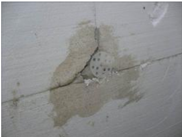
Nedostatečná kvalita kotvení – talíř kotevního prvku zatlačený do tepelné izolace
