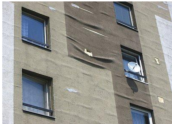
ETICS – separace vnějšího souvrství
