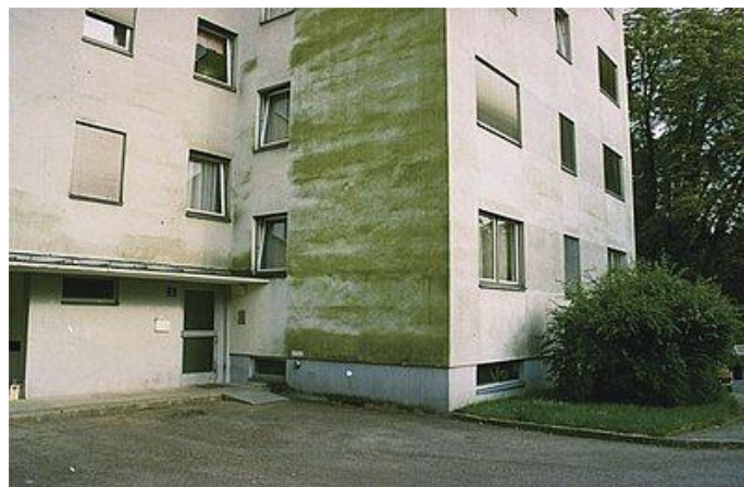
Plísně na fasádě (vznikají na severních a severovýchodních stranách, často se objevují na dříve používaných Akrylátových omítkách)
