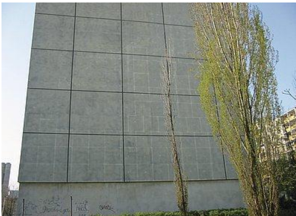
Projevy termodifúze vinou špatného pokládání desek
