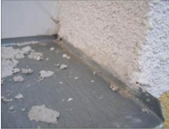
Chybné ukončení oplechování parapetu v ostění
