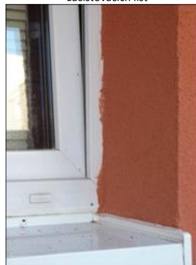
Nesprávné opravení omítky kolem rámu bez použití začíšťovacích lišt
