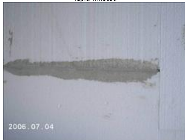
Pokus o vypěnění mezery mezi deskami tepelné izolace
