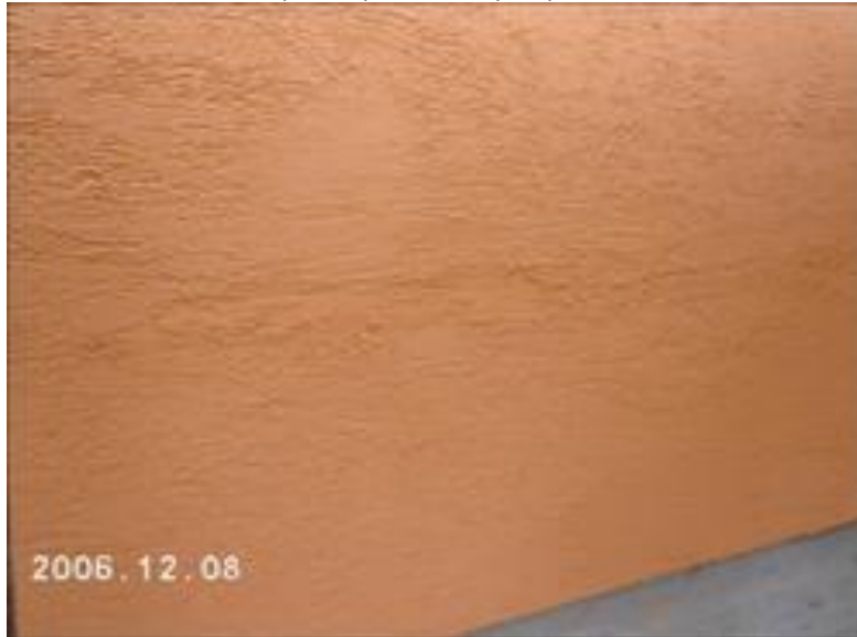
Nesprávně provedená rýhový struktura
