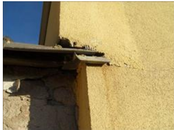
Nesprávné opravení omítky kolem rámu bez použití začíšťovacích lišt
