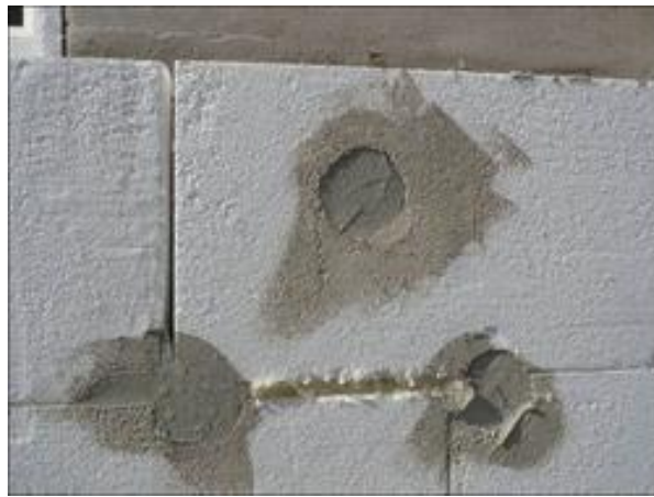
Nedostatečně zatlučený trn kotevního prvku, přes který nelze provádět základní vrstvu
