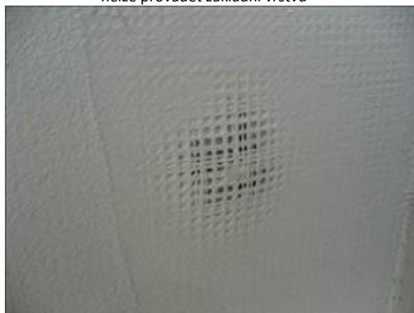
Nedostatečně zatlučený trn kotevního prvku, přes který nelze provádět základní vrstvu
